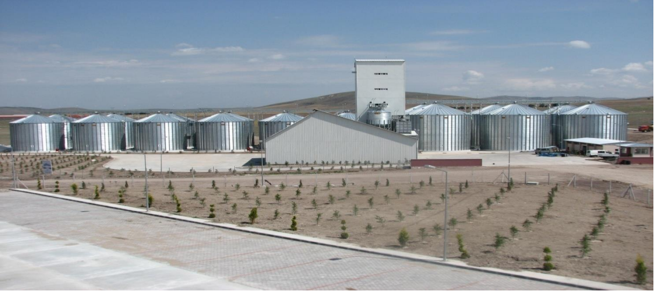
30.000 TON KAPASİTELİ ÇELİK SİLO, TREMİ, MALZEME DEPOSU, GÜVENLİK BİNASI, MAKİNA BİNASI GÖRÜNÜŞÜ
