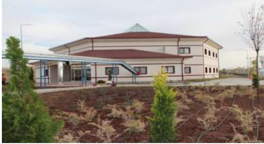
Ahiboz Hububat ve Bakliyat Borsası Satış Salonu Binası Dış Görünüş
