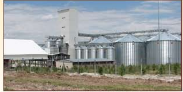
30.000 Tontuk Çelik Silo Tesislerimiz
