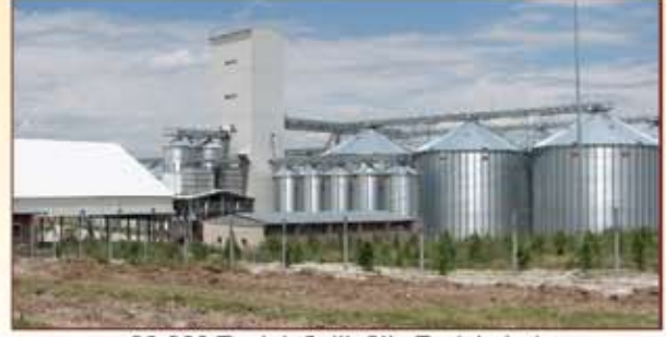
30.000 Tonluk Çelik Silo Tesislerimiz
