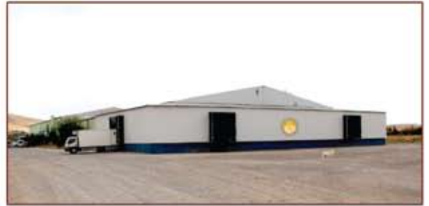
Tek vardiyada 300 büyükbaş, 2500 küçükbaş kesim kapasitesine ve 8 adet soğuk hava deposuna sahip AB standartlarındaki kombinası
